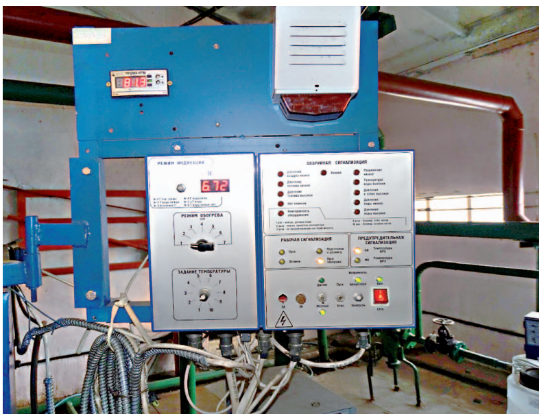
Установлено новое оборудование.
