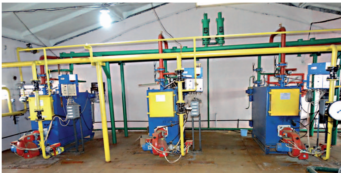
Выполнен большой ремонт котельной.
