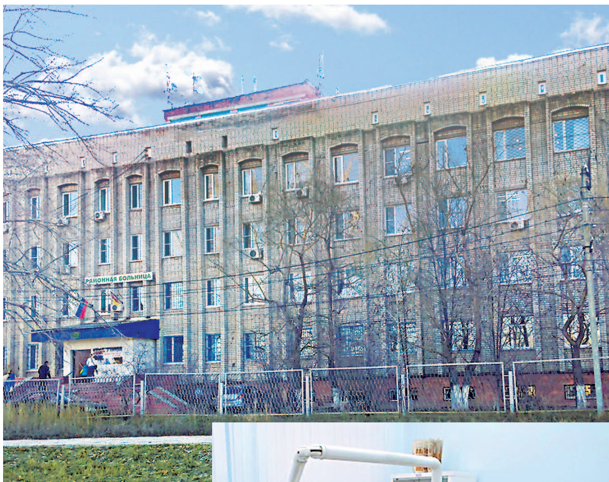
Главный корпус Энгельсской районной больницы.
