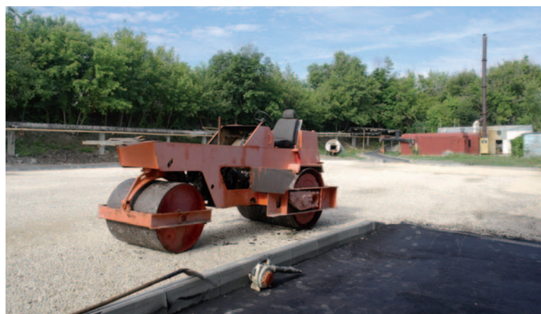
Ведутся работы по благоустройству территории.
